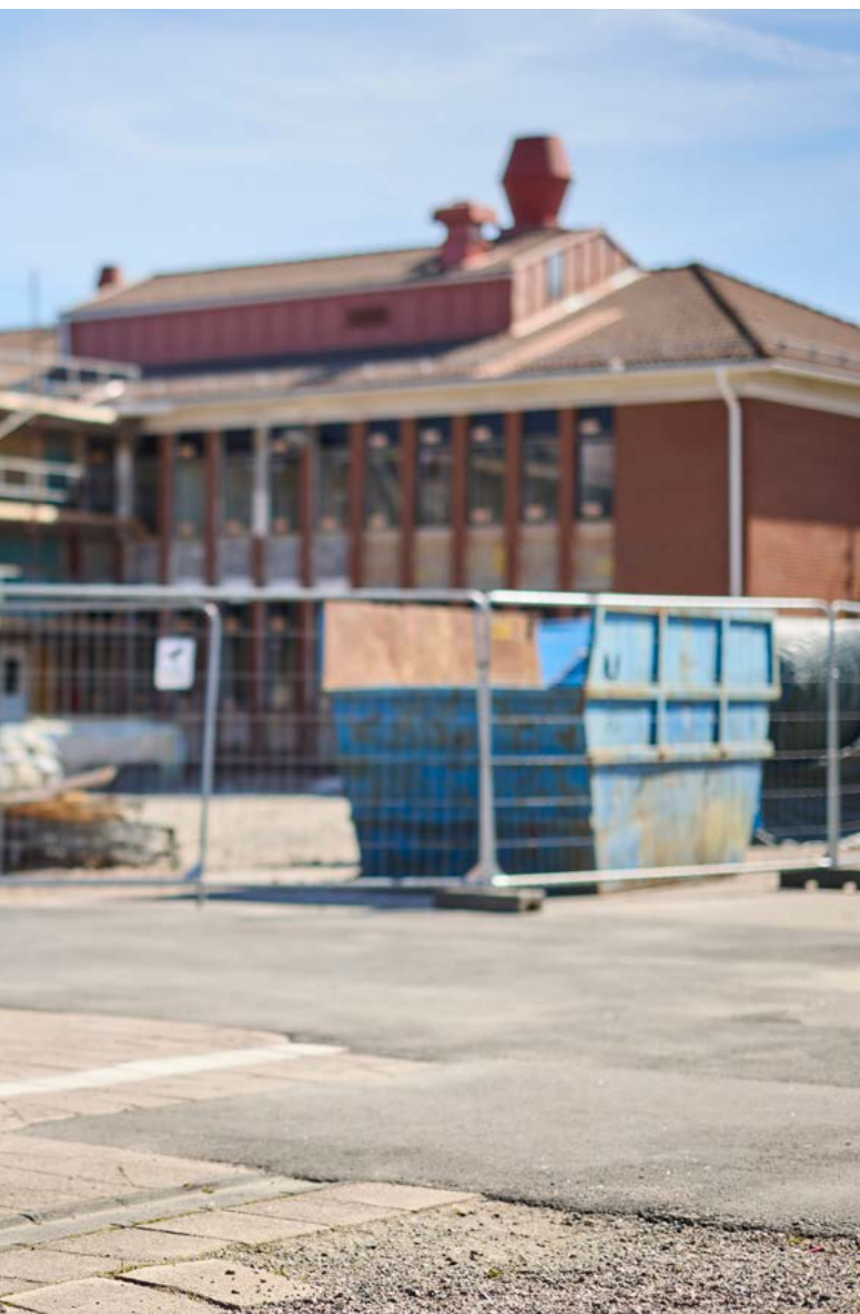
Under sommarlovet kommer byggnadsarbetet att pågå för fullt och till hösten komskolan flyttar in i sina nya lokaler i flygeln mot Allégatan.
